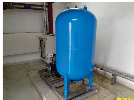
Booster Pump และตู้ควบคุม
